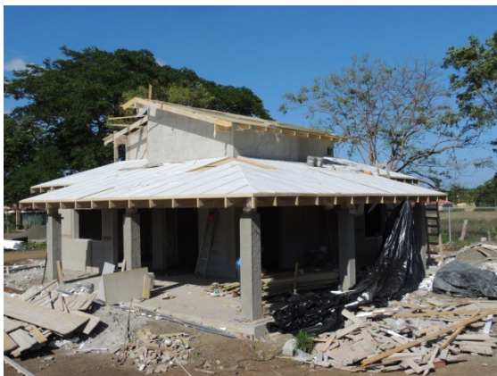
Coibentazione del tetto
