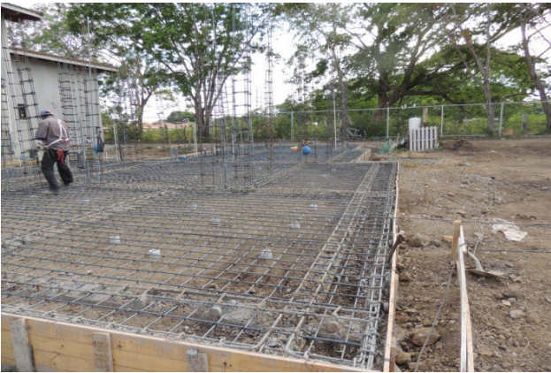
Fondazioni e preparazione armatura in ferro per struttura in cemento armato
