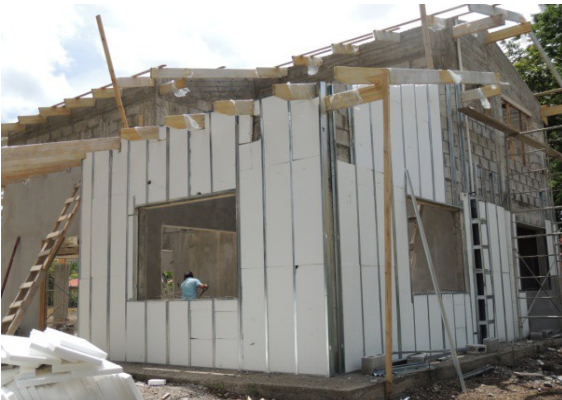
Isolamento delle pareti esterne con sistema 'a cappotto'
