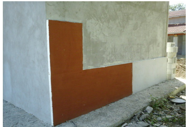
Isolamento delle pareti esterne con sistema 'a cappotto'
